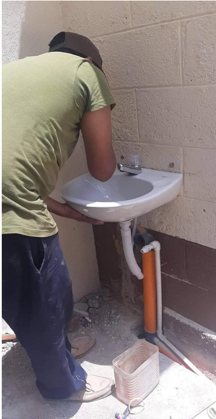
Foto 8: Instalación de lavamanos (tomada por Karen Wong)
