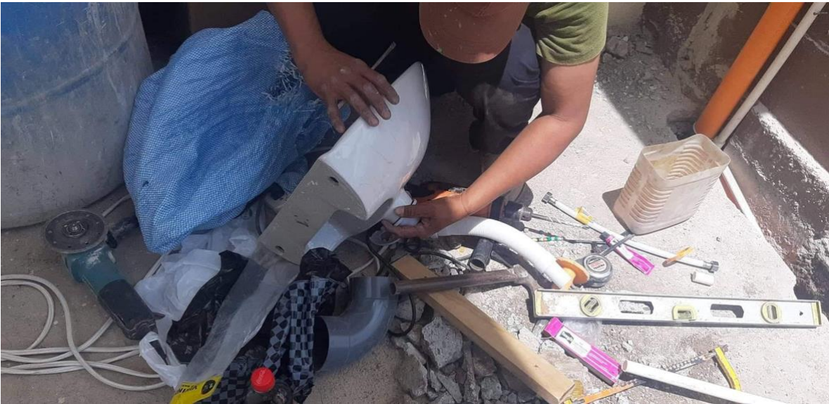
foto 6: armado de lavamanos antes de la instalación (tomada por Karen Wong)
