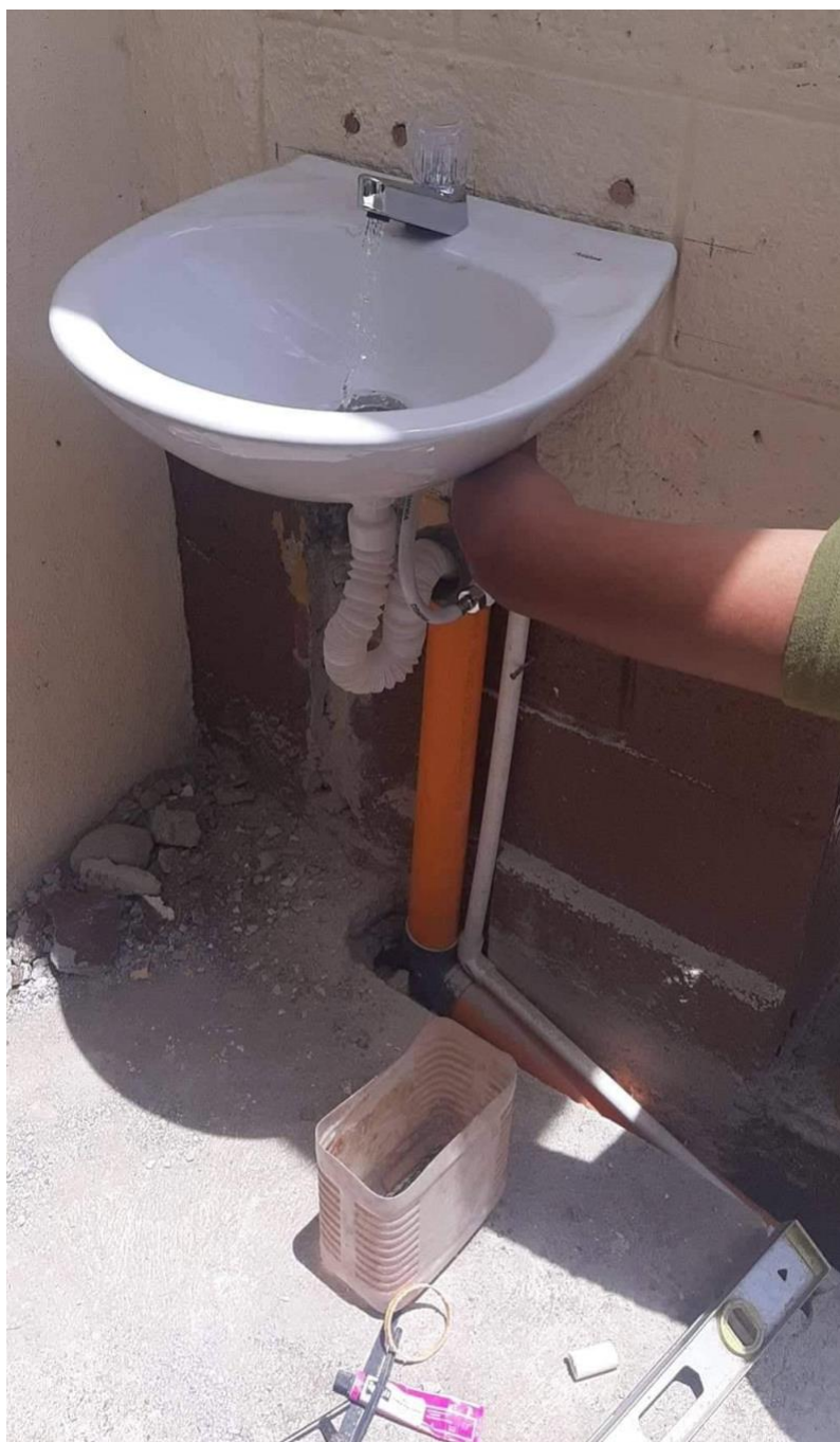
Foto 10: Prueba de la conducción de agua (tomada por Karen Wong)
