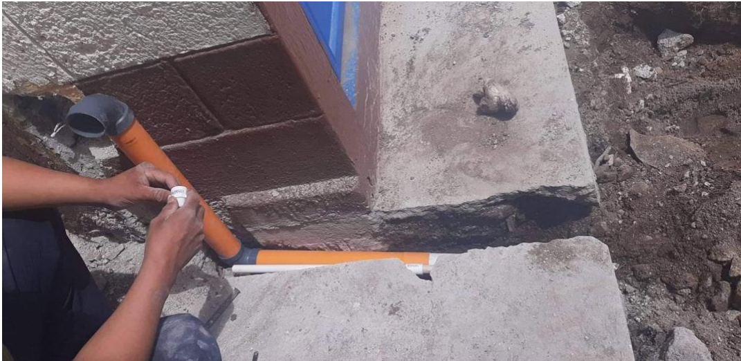
Foto 3: instalaciones de la tubería (tomada por Karen Wong)
