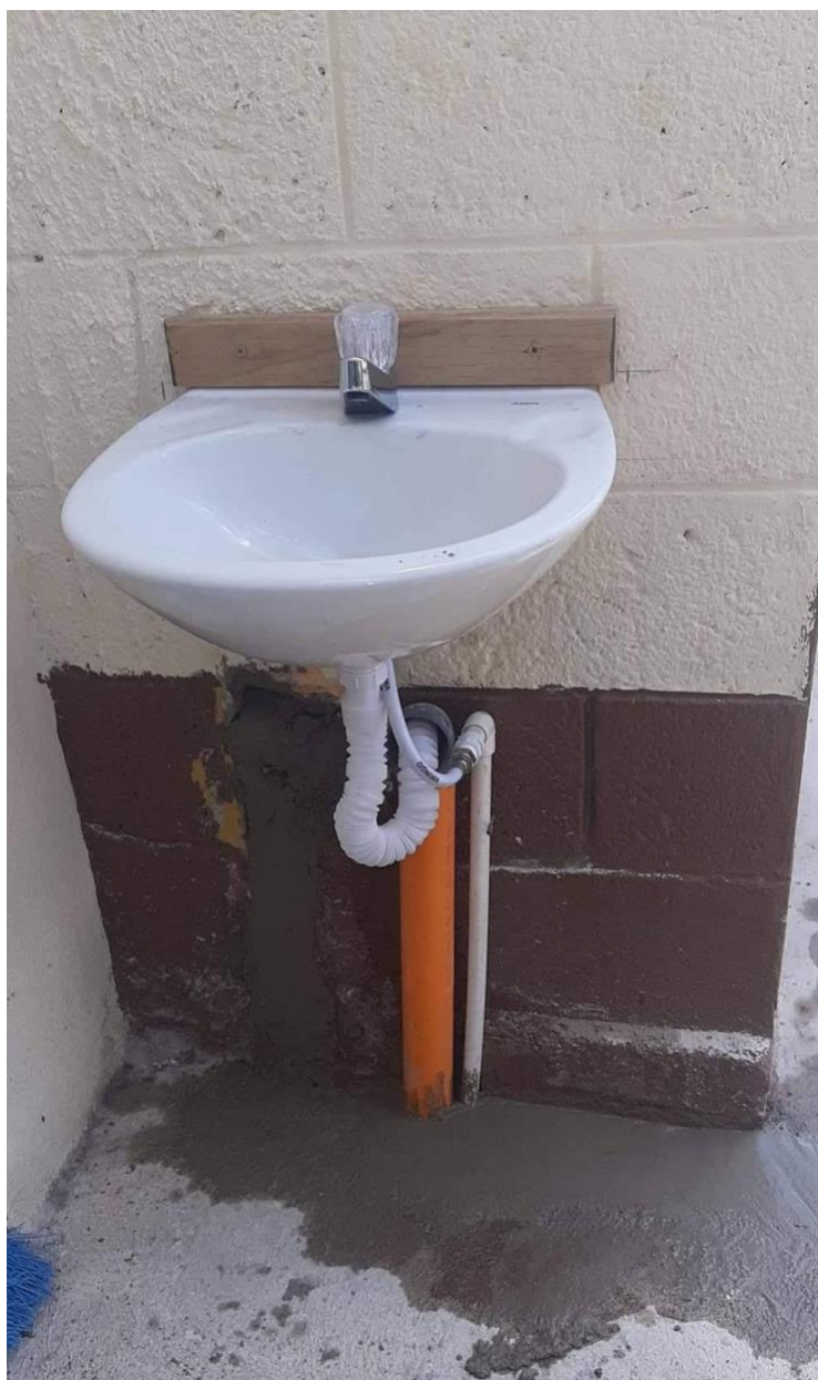
Foto 11: realización de torta de cemento, que previamente habían quitado para la instalación de la tubería. Instalación completa de lavamanos. (tomada por Karen Wong)
