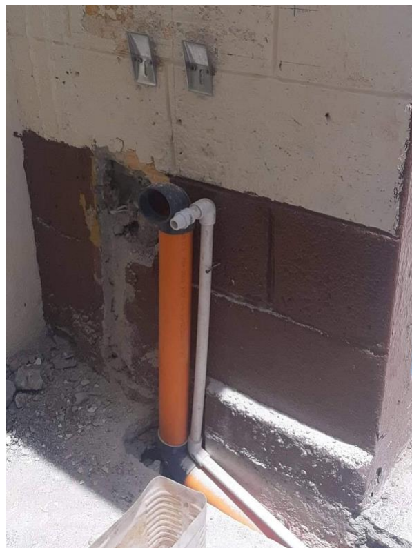
Foto 4: la tubería ya está instalada, para instalar el lavamanos (tomada por Karen Wong)
