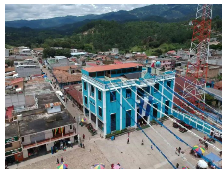
Figura 80, Municipalidad de Zacualpa, Quiché, (fotografía propia, 2020.)
