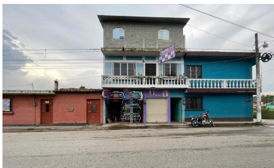
Figura 96. Viviendas al Sur del terreno, (Fotografía: Propia, 2022)
