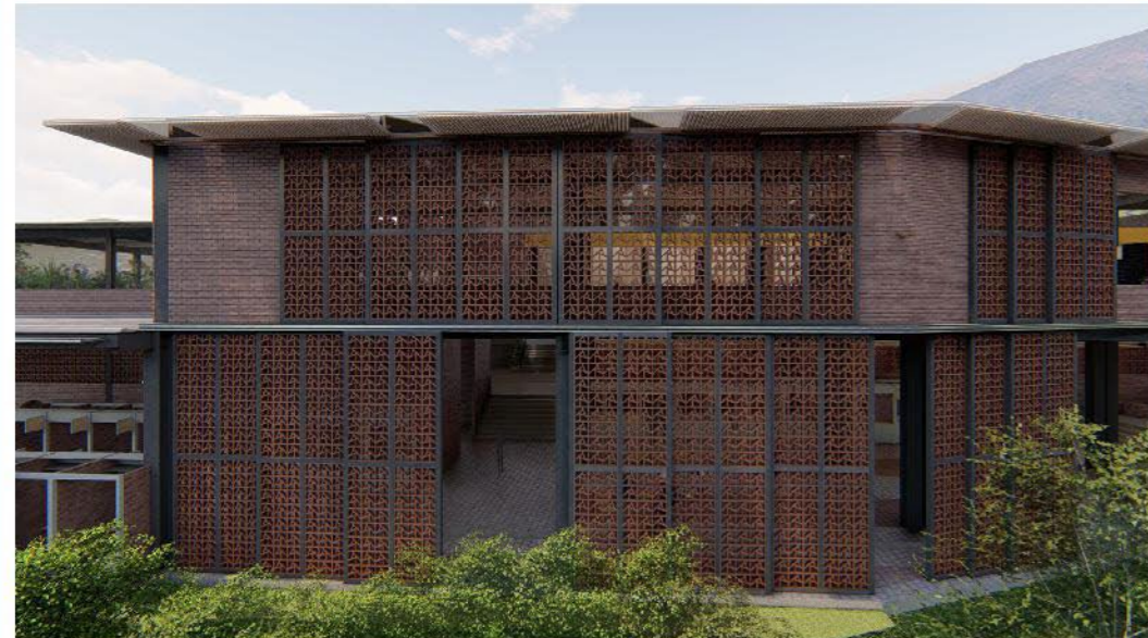
Paneles móviles de celosía de ladrillo
