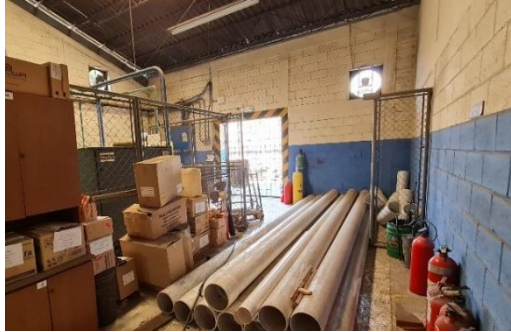
Figura 48. Vista posterior del cuarto de compresores
