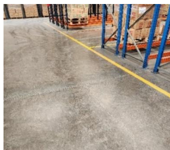
Figura 5. Pisos del almacén de productos terminados
