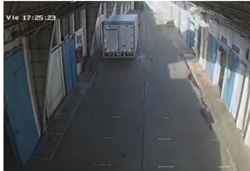
Figura 13. Vista general del pasillo de acceso hacia las bodegas
