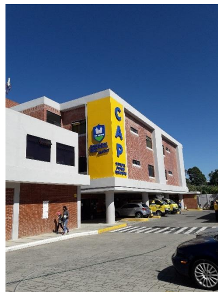
Fotografía 24. Vista exterior del CAP, a la derecha se aprecia el edificio remodelado, a la izquierda el módulo anexo nuevo. En la fachada de orientación sur, no se realizó tratamiento para evitar el soleamiento, en área de sala de reuniones y encamamiento de pediatría. Fotografía: propia (2022)
