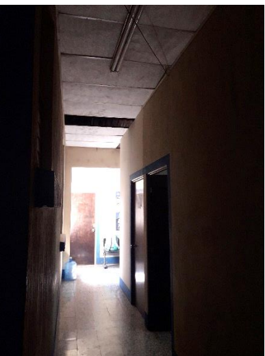
Fotografía 16. Vista de pasillo hacia oficinas. Fotografía: propia (2022)
