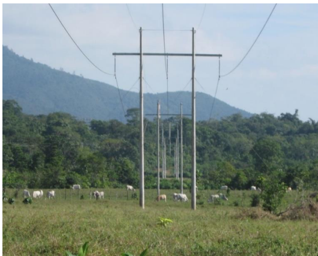
Figura 9. Configuración H de postes
