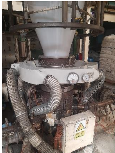
Figura 5. Mangueras de distribución de aire frío del IBC
