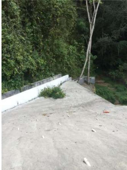
Apéndice 4. Km 39 + 700 RN 10.- Lado derecho. Obra de protección en talud de relleno y canalización de aguas de cunetas.
