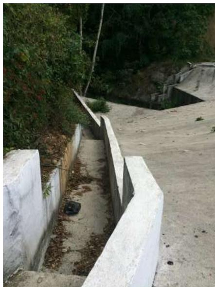
Apéndice 5. Km 39 + 700 RN 10.- Lado derecho. Obras de protección para proteger la erosión de los taludes.
