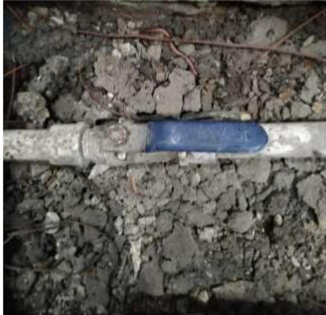
*Nota.* Válvulas de control de agua tipo bola que aíslan una parte de la tubería y bloquean el paso de fluido al rotarse. Elaboración propia.
