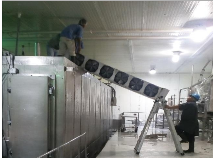
Figura 8. Trabajo en altura
