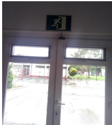
Figura 31. Ejemplo de señalización para ruta de evacuación en la empresa procesadora de carne
