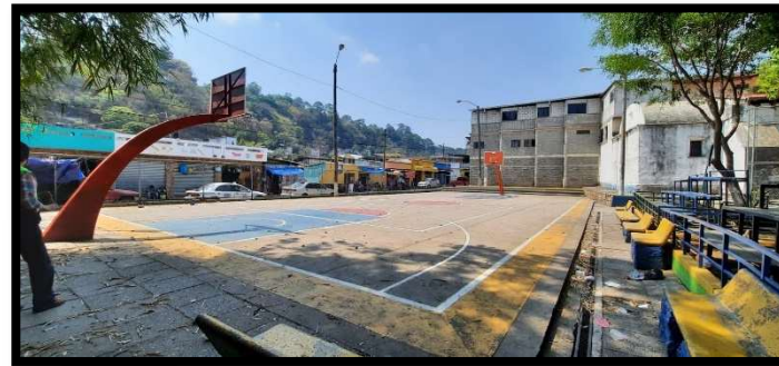
6 Vista adentro del proyecto, el cual considera conservar parte de la estructura para su restauración.
