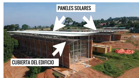
Figura 22: Aspecto de doble techo, elaboración propia en base a imagen de www.plataformaarquitectura.cl – Walsh, Niall. Abril 2019
