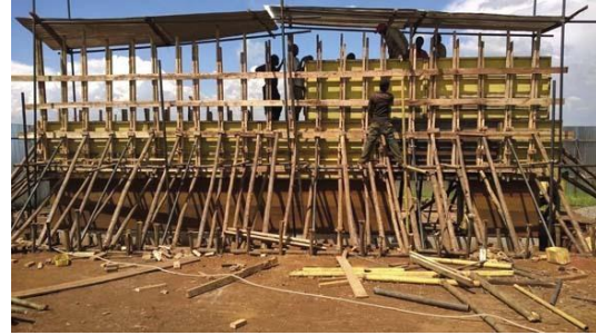
Figura 28: Apisonamiento de muros, Imagen de Plataformaarquitectura.cl – Walsh, Niall. Abril 2019
