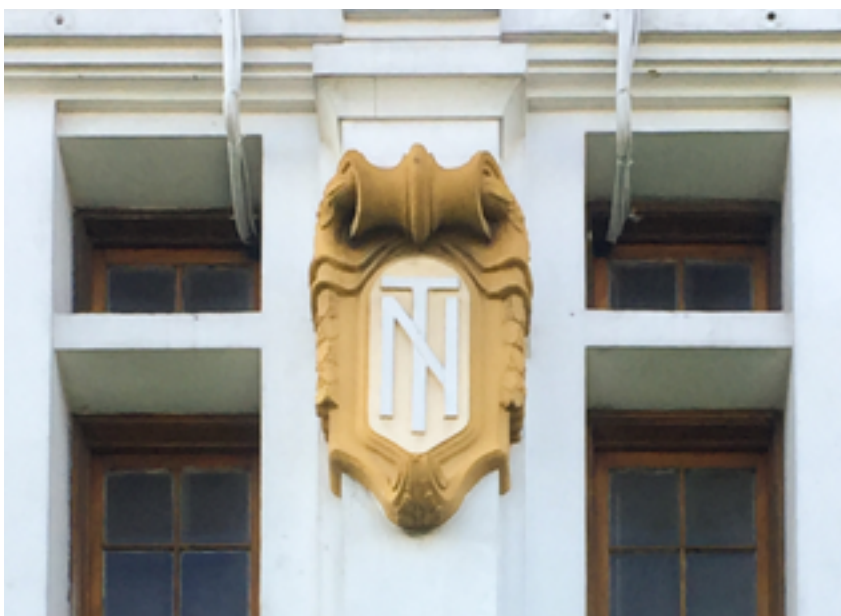
Figura 81 - Cartela y monograma en columnas del edificio de la Tipografía Nacional.
