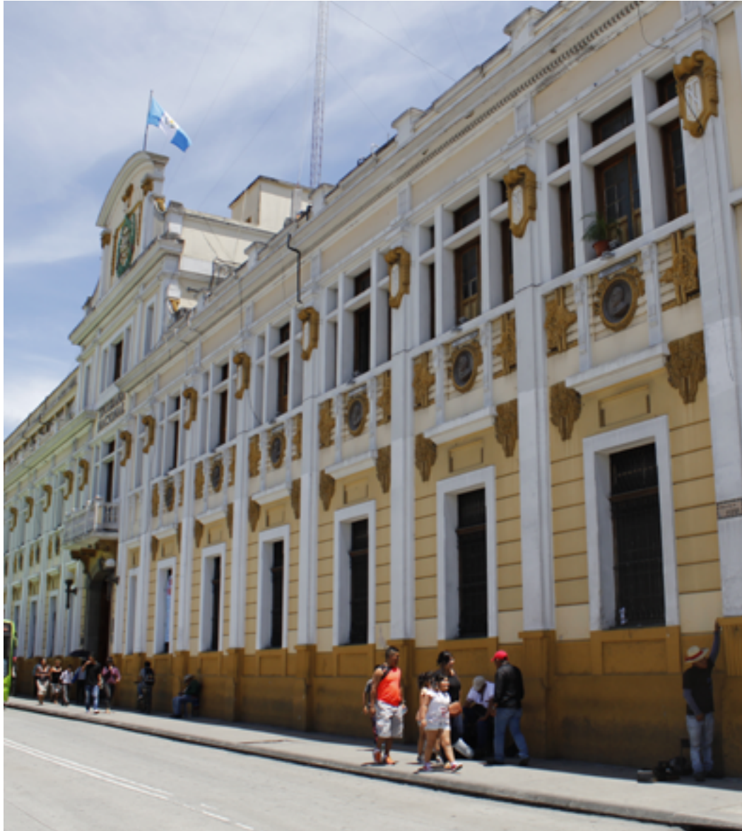
Figura 1 - Edificio de la Dirección General del Diario de Centro América y Tipografía Nacional y de la Radio TGW.
