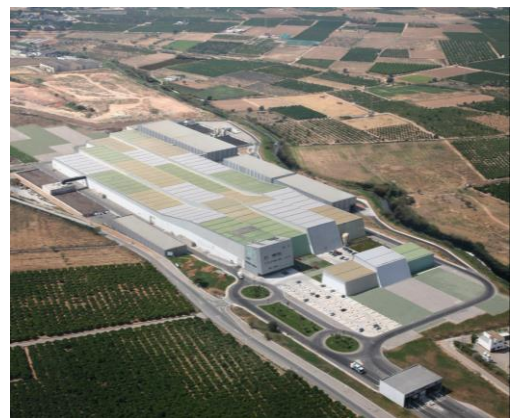
Figura 34. Fotografía aérea, Planta de Tratamiento de Desechos Valencia-España. Fuente: Archdaily 2023
