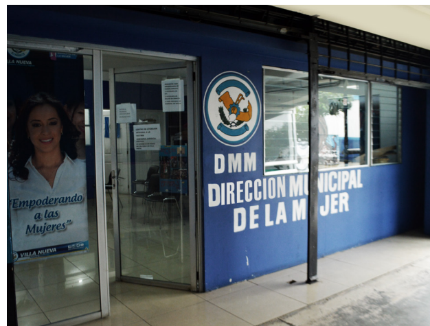
INGRESO A DMM VILLA NUEVA (Antes denominada como OMM) FUENTE: Fernando Ruiz
