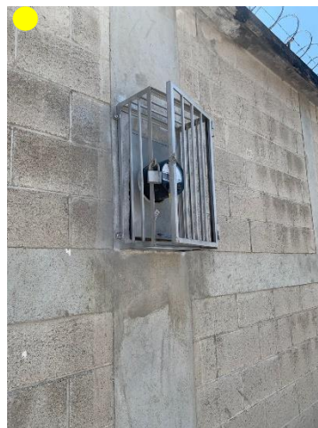
Figura 67 Contador eléctrico del terreno Fuente: elaboración propia
