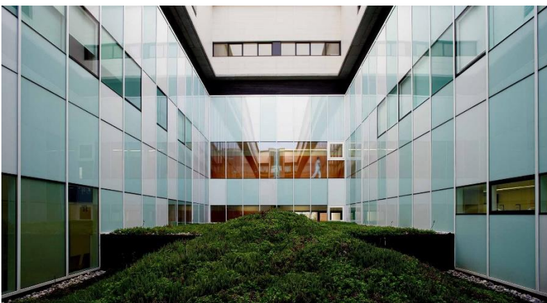
FIGURA 14. Vista de patio interior verdes Hospital de Mollet FUENTE: Roca Gallery
