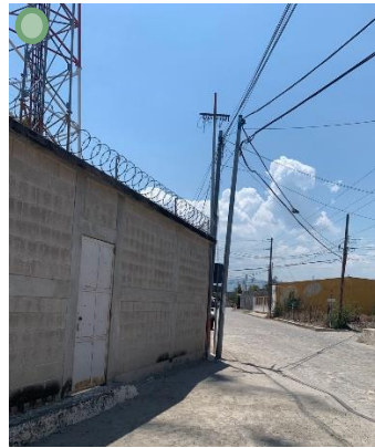
Figura 64 Cableado eléctrico del Terreno Fuente: elaboración propia
