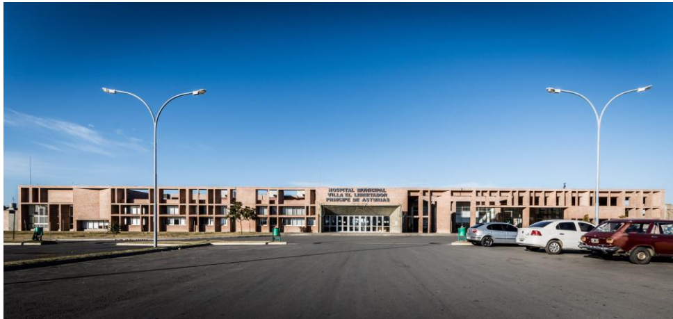
FIGURA 19. "Hospital Municipal Villa El Libertador Príncipe de Asturias" FUENTE: https://www.archdaily.cl
