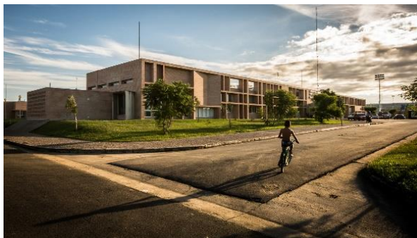
FIGURA 25 Fachada Hospital Municipal Villa El Libertador Príncipe de Asturias" FUENTE: https://www.archdaily.cl
