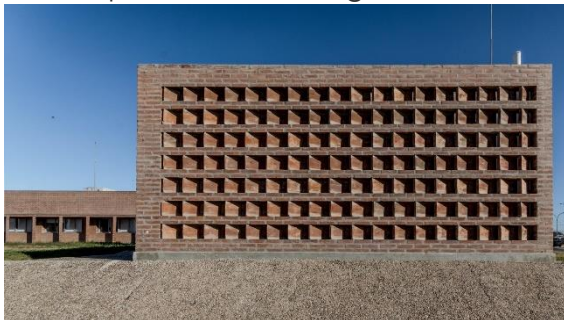
FIGURA 33 Detalle de parteluces Hospital Municipal Villa El Libertador Príncipe de Asturias" FUENTE: https://www.archdaily.cl
