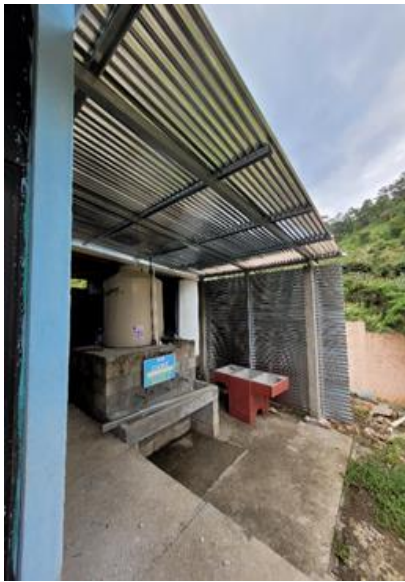
Galera terminada y la pila instalada.
