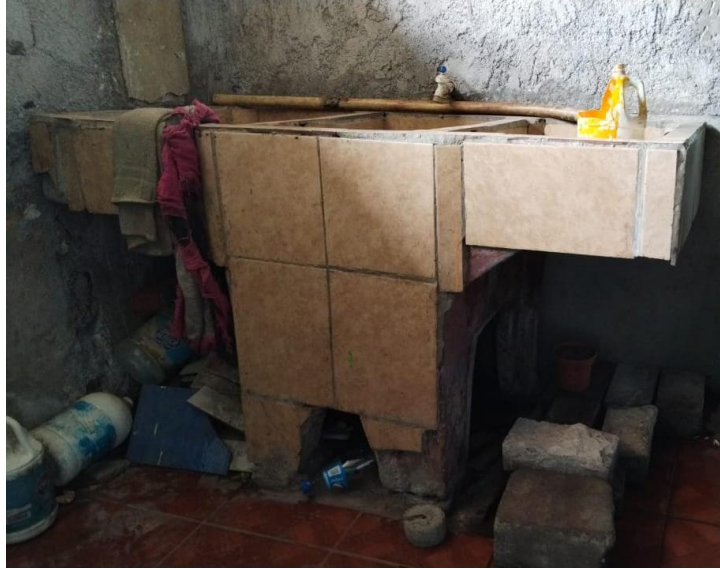
Imagen 1: Estado de la antigua pila de la escuela “Villa de Guadalupe”.
