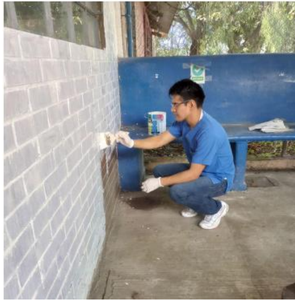
Imagen 6: Inicio de la etapa de ejecución del proyecto de mejoras a la clínica dental.
