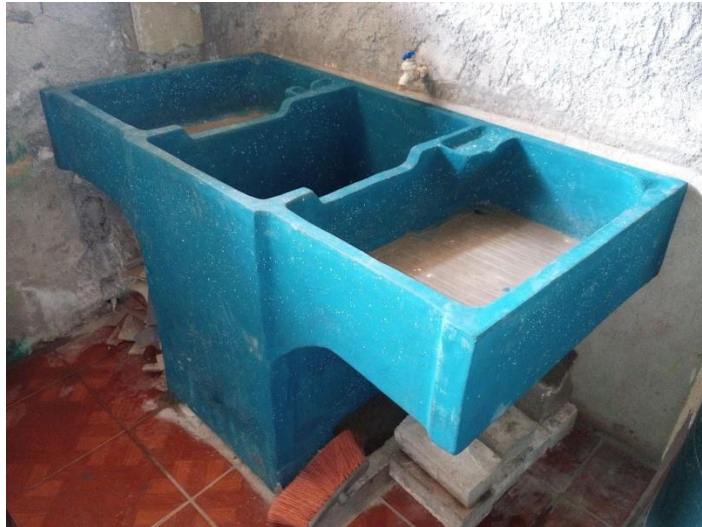
Imagen 4: Pila nueva instalada.
