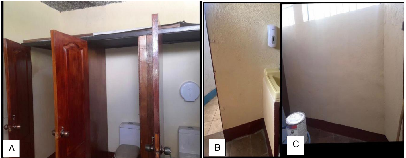
Figura No. 4: A= Colocación de dispensador de papel, colocación de tapa y tablero a los baños; B= Colocación de dispensador de jabón líquido; C= Pintado de paredes.
