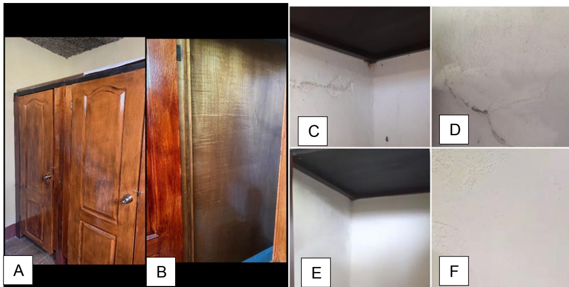
Figura No. 3: A= Barnizado de puertas de madera; B= Cambio de regletas de madera y barnizado de divisiones de madera; C, D= Paredes sanitarios deterioradas; E, F= Paredes de los sanitarios reparadas con monocapa blanco y pintura de color marfil.
