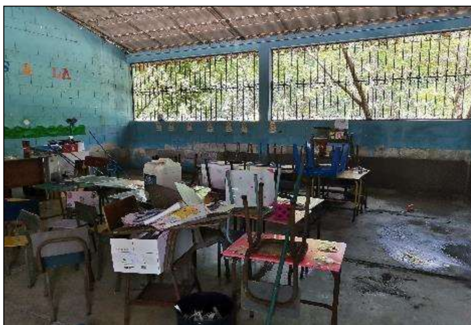
Fotografía final del proyecto de Maritza Anabelen Solares Afre. (Chiquimulilla, Santa Rosa 2022). Archivos de Ejercicio Profesional Supervisado en aldea Los Macizos, Chiquimulilla, Santa Rosa. Nota: Se puede observar que el repello fue realizado en las áreas erosionadas y se brindó un nuevo aspecto al salón.
