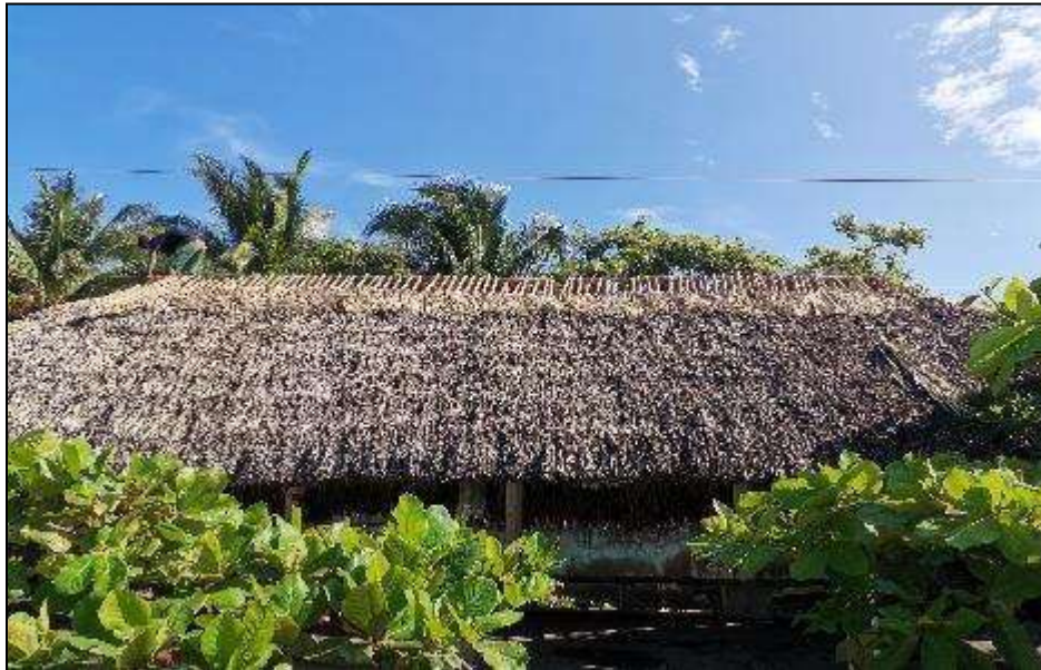
Fotografía inicial del proyecto de Maritza Anabelen Solares Afre. (Chiquimulilla, Santa Rosa 2022). Archivos de Ejercicio Profesional Supervisado en aldea Los Macizos, Chiquimulilla, Santa Rosa. Nota: se puede observar que el caballete central del rancho ya no contaba con palma, por lo que se encontraba en mal estado y limitaba su uso.
