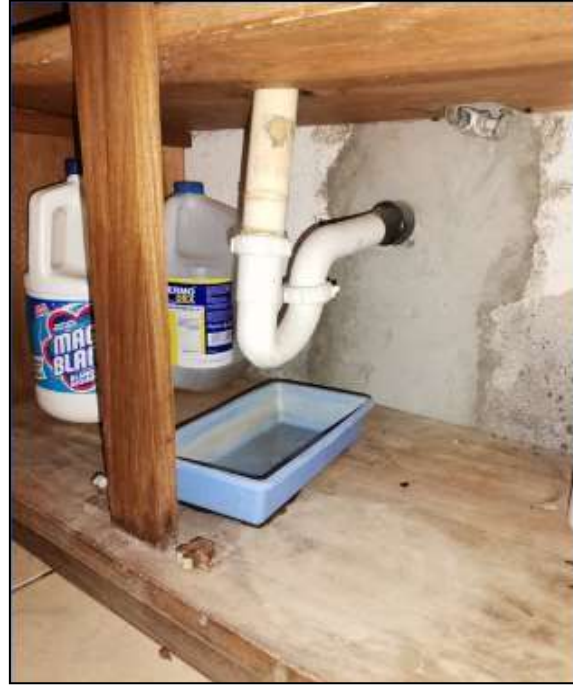
Fotografía inicial del proyecto de Maritza Anabelen Solares Afre. (Chiquimulilla, Santa Rosa 2022). Archivos de Ejercicio Profesional Supervisado en aldea Los Macizos, Chiquimulilla, Santa Rosa. Nota: Se puede observar el mal estado de la tubería y del mueble que conforman el área de lavado en la clínica.
