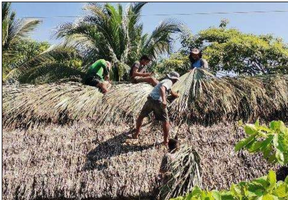
Fotografía del proceso del proyecto de Maritza Anabelen Solares Afre. (Chiquimulilla, Santa Rosa 2022). Archivos de Ejercicio Profesional Supervisado en aldea Los Macizos, Chiquimulilla, Santa Rosa. Nota: se puede observar la colocación de nueva palma en el caballete central del rancho.
