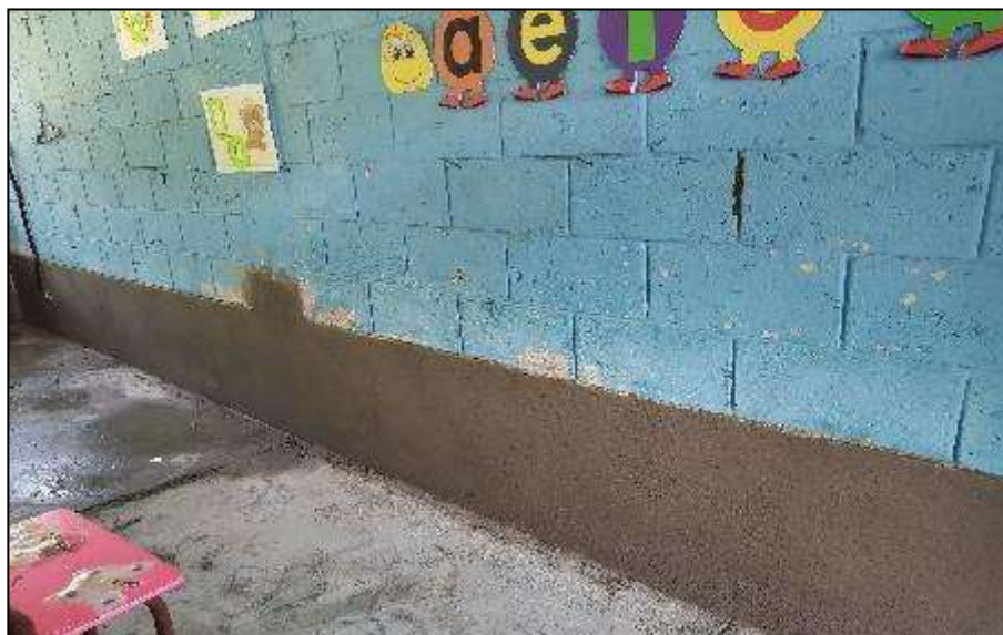
Fotografía final del proyecto de Maritza Anabelen Solares Afre. (Chiquimulilla, Santa Rosa 2022). Archivos de Ejercicio Profesional Supervisado en aldea Los Macizos, Chiquimulilla, Santa Rosa. Nota: Se puede observar que el repello fue realizado en las áreas erosionadas y se brindó un nuevo aspecto al salón.
