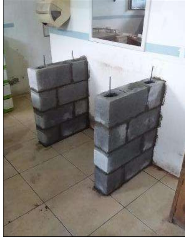
Fotografía del proyecto de Maritza Anabelen Solares Afre. Archivos de Ejercicio Profesional Supervisado en aldea Los Macizos, Chiquimulilla, Santa Rosa. Nota: proceso de fundición del cemento para el nuevo lavatrastos del área de esterilización diseñada.
