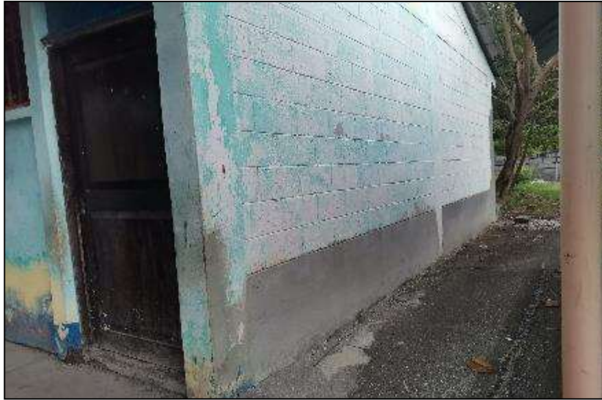
Fotografía final del proyecto de Maritza Anabelen Solares Afre. (Chiquimulilla, Santa Rosa 2022). Archivos de Ejercicio Profesional Supervisado en aldea Los Macizos, Chiquimulilla, Santa Rosa. Nota: Se puede observar que el repello fue realizado en las áreas erosionadas y se brindó un nuevo aspecto al exterior del salón.
