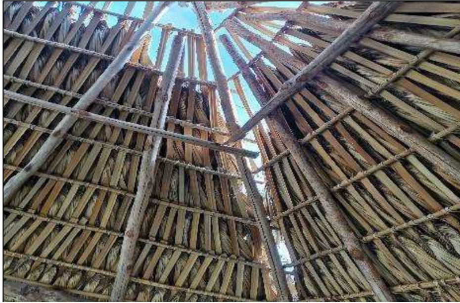
Fotografía inicial del proyecto de Maritza Anabelen Solares Afre. (Chiquimulilla, Santa Rosa 2022). Archivos de Ejercicio Profesional Supervisado en aldea Los Macizos, Chiquimulilla, Santa Rosa. Nota: se puede observar que el caballete central del rancho ya no contaba con palma, por lo que se encontraba en mal estado y limitaba su uso.
