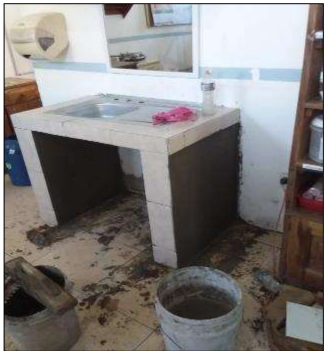
Fotografía del proyecto de Maritza Anabelen Solares Afre. Archivos de Ejercicio Profesional Supervisado en aldea Los Macizos, Chiquimulilla, Santa Rosa. Nota: se observa la construcción de la base para el lavatrastos, y la colocación de azulejo para que sea un área fácil de limpiar.
