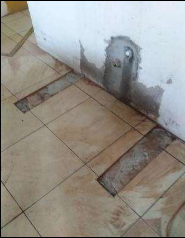
Fotografía del proyecto de Maritza Anabelen Solares Afre. Archivos de Ejercicio Profesional Supervisado en aldea Los Macizos, Chiquimulilla, Santa Rosa. Nota: proceso de fundición del cemento para el nuevo lavatrastos del área de esterilización diseñada.
