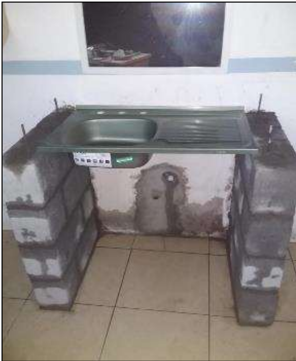
Fotografía del proyecto de Maritza Anabelen Solares Afre. Archivos de Ejercicio Profesional Supervisado en aldea Los Macizos, Chiquimulilla, Santa Rosa. Nota: se observa la construcción de la base para el lavatrastos, y la colocación de azulejo para que sea un área fácil de limpiar.
