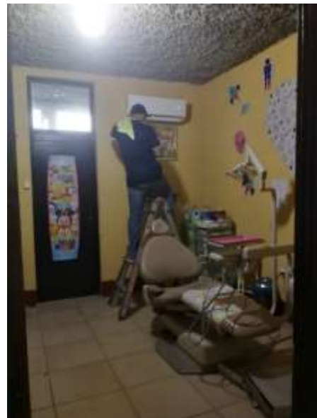
Fotografía 14: Mantenimiento del aire acondicionado.
