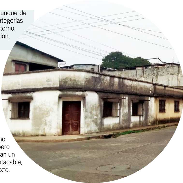
Figura 150. Inmueble en la 2a calle 8-40, zona 3, inventariado en la Nómina, se propone como categoría C.
