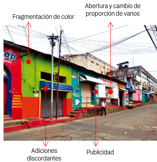
Figura 155. Daños y alteraciones, inmueble 3ª avenida 1-54, zona 3. Fuente: Elaboración propia, estudio de campo mayo 2021.
