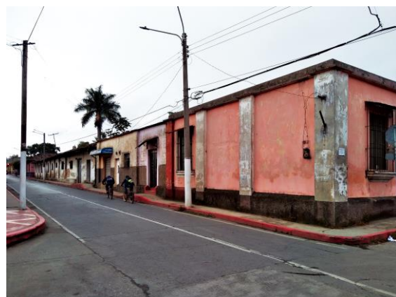
Figura 134. Ejemplo de homogeneidad debido a la poca división predial y misma altura de construcción.
