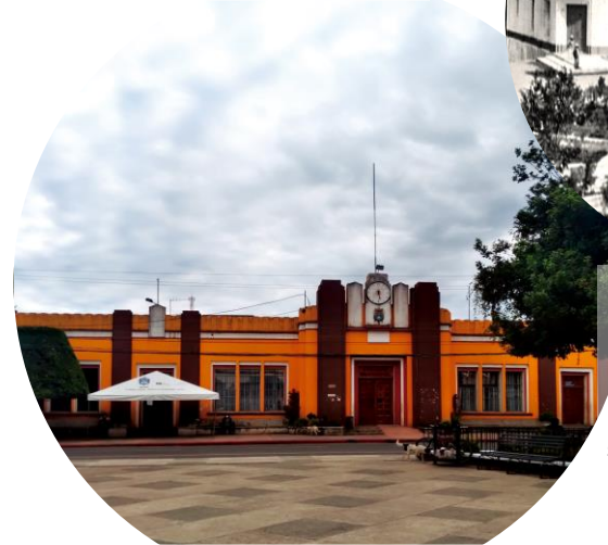
Figura 100. Vista actual del Edificio Municipal.
