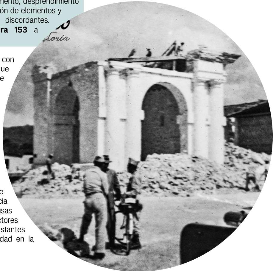
Figura 152. Demolición de la Torre del Reloj, 8 a 20 de marzo de 1956.
