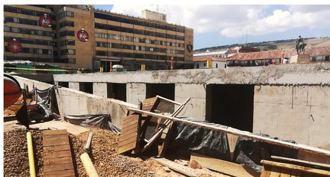
Figura 58. Construcción de los sanitarios subterráneos en Plaza Bolívar.
