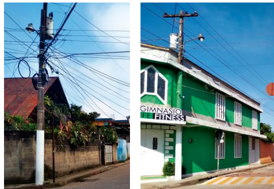
Figura 133. Luminarias de tipo canasta con lámpara de mercurio (izquierda) y ahorradora (derecha). Se observa la falta de protección en la luminaria. Fuente: Elaboración propia, estudio de campo mayo 2021.
