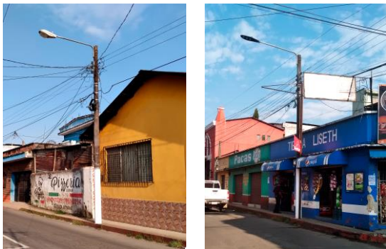
Figura 132. Luminarias de tipo Sodio (izquierda) y tipo LED (derecha). Fuente: Elaboración propia, estudio de campo mayo 2021.
