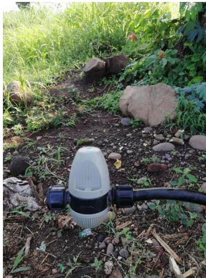
Figura 6. Regulador de presión utilizado para evitar variabilidad por presión.
