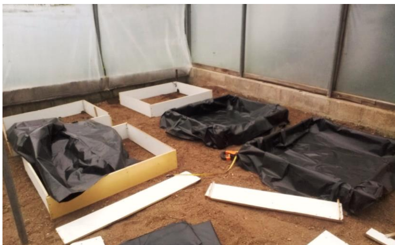
Figura 8. Elaboración de las cajas para instalación de materiales orgánicos de cada tratamiento.
