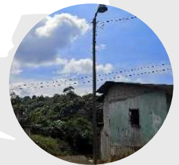
Luminaria sobre la Calle
