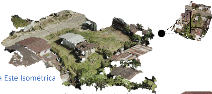
Figura 70: Vista Este isométrica Fuente: Fotografía propia
