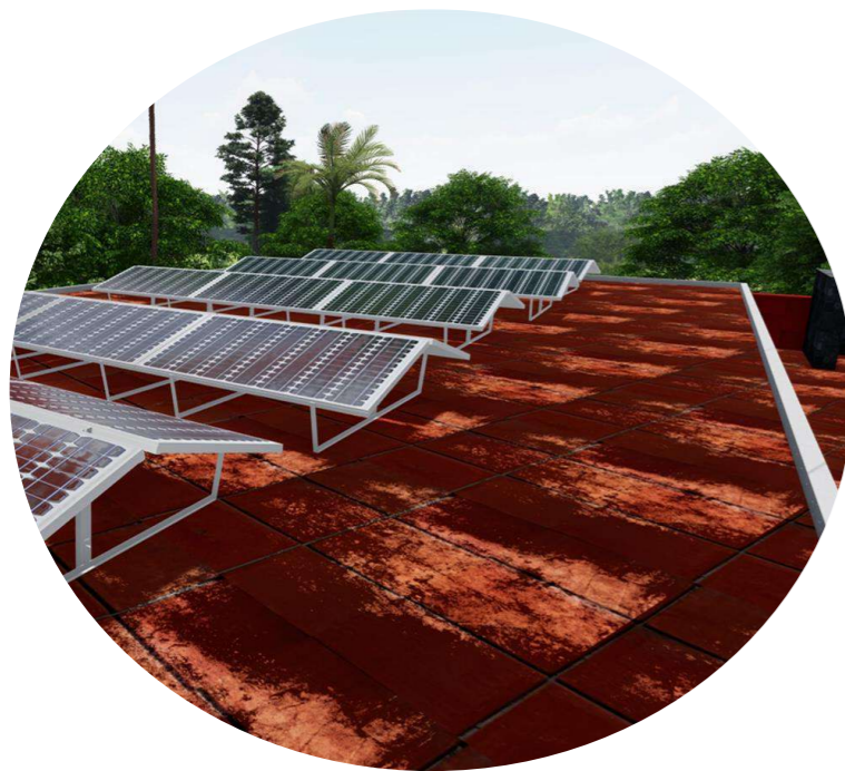
Imagen de Paneles Fovoltavicos + Aislamiento de Cubierta Térmica
