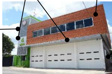
Figura 35: Estación de Bomberos Municipales Fuente: Elaboración propia
