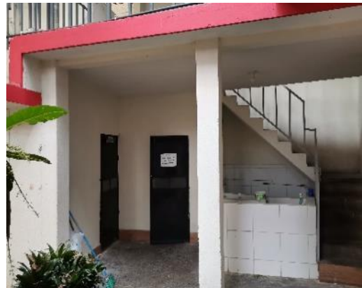
Imagen 17. Se observa el módulo de gradas, bodega y servicios sanitarios de Casa Joven Villa Nueva. Fuente: Archivo Secretaría de Bienestar Social
