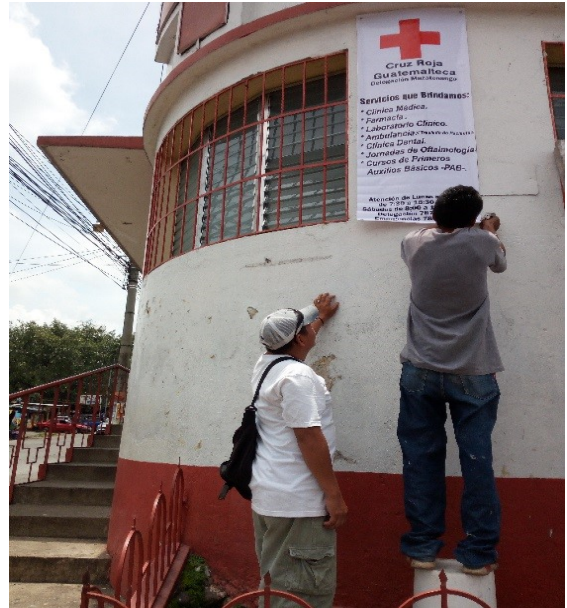
Vinílica colocada en ingreso principal de CRGDM.
