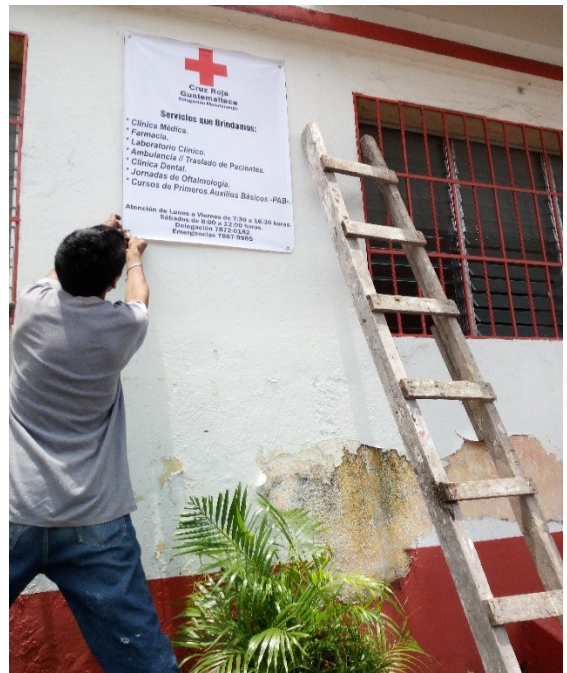
Vinílica instalada en Avenida Ángel Claudio Calderón.
