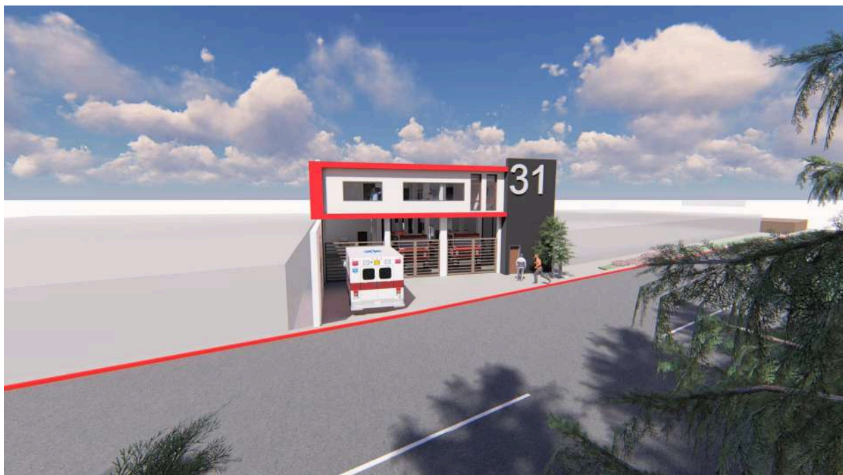
01 - VISTA FACHADA FRONTAL
