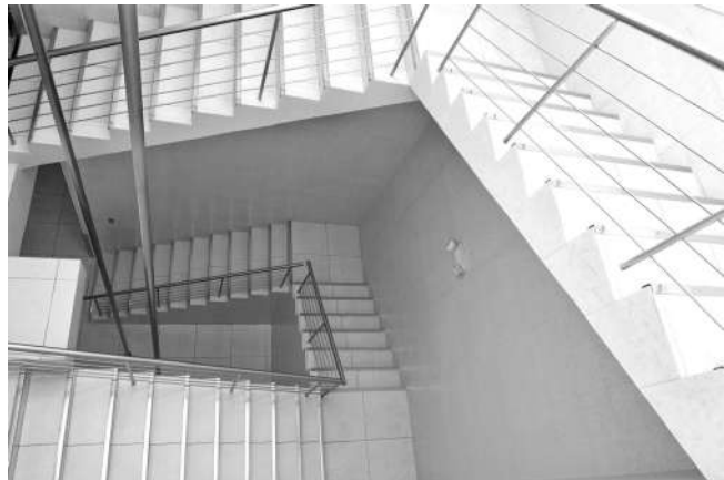
Fotografía 06: Gradas Estación de Bomberos Municipales núm 2.
