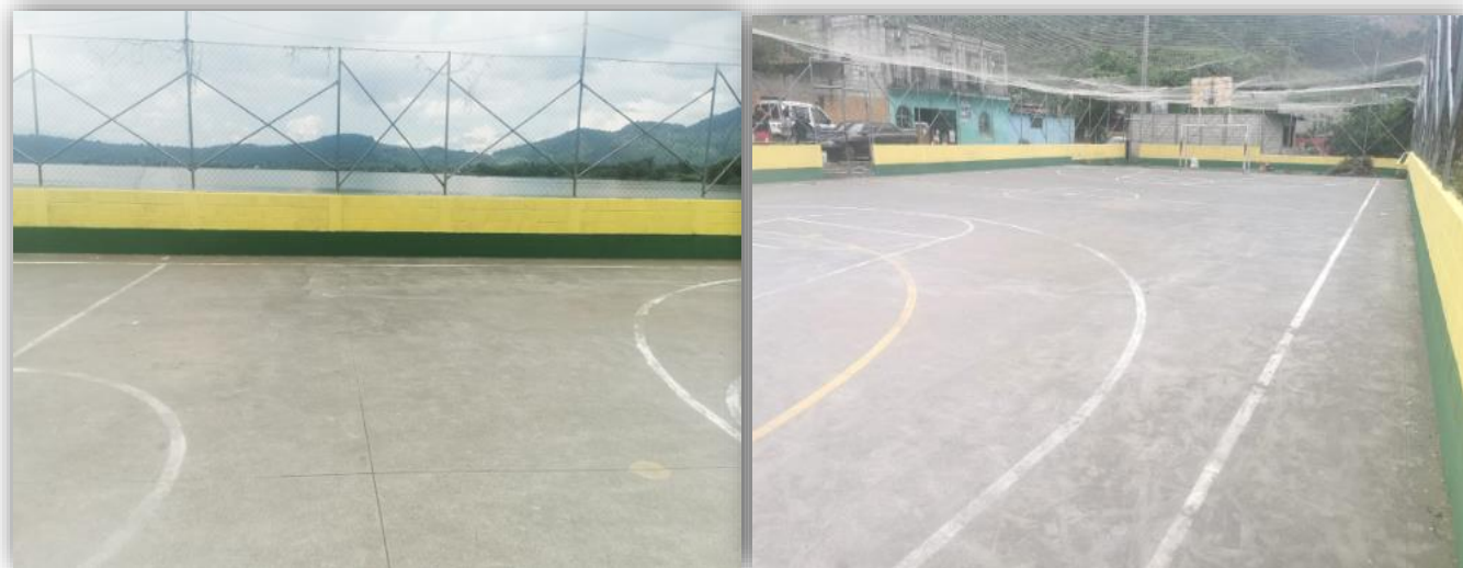
Imagen 6. Paredes perimetrales ya pintadas. Fuente: EPS realizado en Infancia con Futuro.
