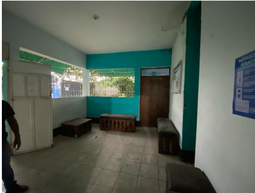
Figura 14. Sala de espera del Módulo Odontológico. Se pueden observar los dos balcones abiertos sin ventana, lo que ofrece adecuada ventilación del área.
