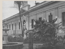
Edificio Antigua Facultad de Medicina
