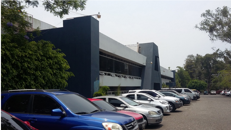
Fotografía del Edificio T2 de La Facultad de Arquitectura de la Universidad de San Carlos de Guatemala, tomada 10 de marzo de 2016
