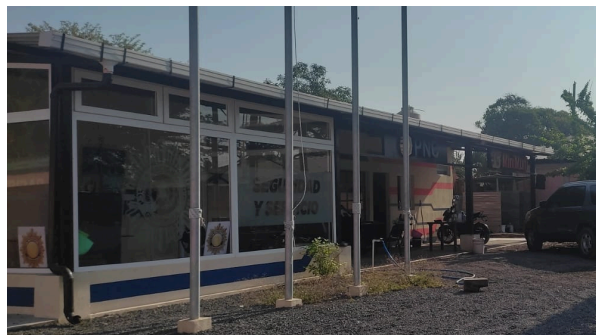
Figura n.º 53. Subestación de Policía Fuente: elaboración propia
