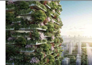
Ilustración 14: Bosques verticales del arquitecto Stefano Boeri Architetti / China, Huanggang y Nanjing/ Año 2021 Fuente: https://www.traveler.es/experiencias/articulos/china-inaugurara-dos-primeros-bosques-verticales-stefano-boeri-febrero-y-mayo-de-2021/19750
