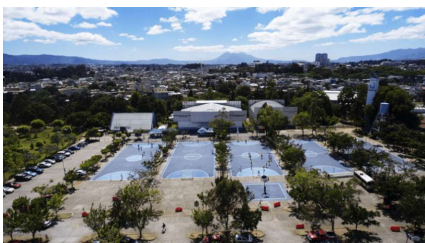
Ilustración 34: Vista a parqueo de parque Erick Barrondo
