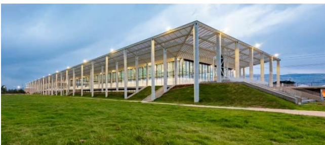
Ilustración 59: Vista exterior del Centro deportivo, recreativo y cultural del Parque Metropolitano El Tunal
