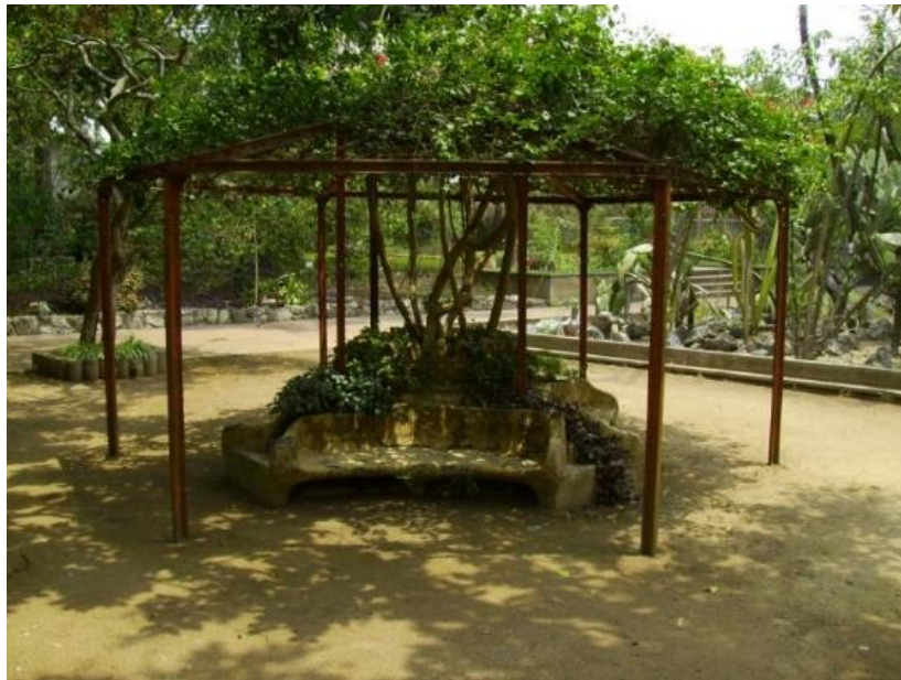
Figura 8. Glorieta 1, elaborada en mampostería de barro y calicanto. Leonel Hernández, Departamento de Estudios y Planificación, CECON, USAC. 2018
