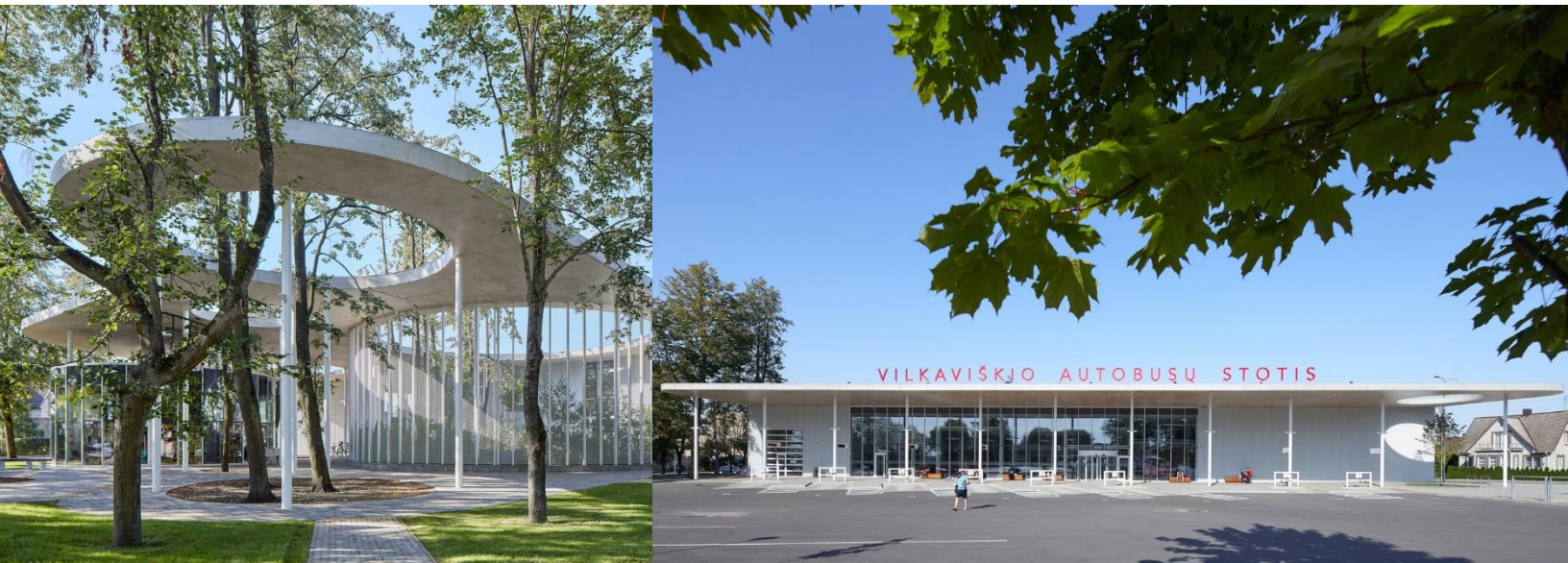
FIGURA 27: Morfología y caracterización del edificio de estación para autobuses de Vilkaviskis, Lituania, https://www.archdaily.com/956510/vilkaviskis-bus-station-balcytis-studija-balcytis-studija?ad_source=search&ad_medium=projects_tab .
