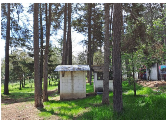
Caseta de pozo y cuarto eléctrico provisional.
