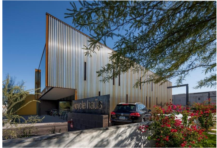
Fotografía 9: Bicycle Haus por DeBartolo Architects. Arizona. Fotografía por Timmerman Photography. Fuente: Archdaily.
