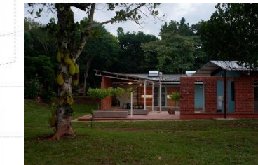
Figura 20 Fotografía de techos con paneles solares Fuente: https://www.archdaily.com/mpirigiti-rural-training-center-studio
