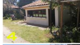
4 AREA DE COCINA
