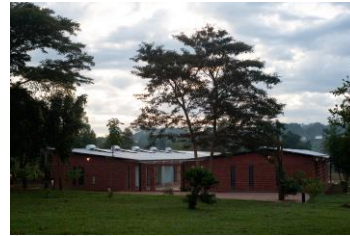
Figura 19 Fotografía de techos con paneles solares Fuente: https://www.archdaily.com/mpirigiti-rural-training-center-studio
