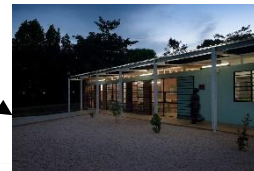
Figura 17 Fotografía área Comedor Fuente: https://www.archdaily.com/mpirigiti-rural-training-center-studio
