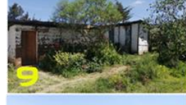
9 BODEGA Y LETRINAS
