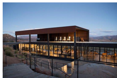
Figura 54. En la vinícola la utilización de la transparencia para aprovechar la luz natural en los ambientes, dividir espacios y dar mayor visibilidad.
