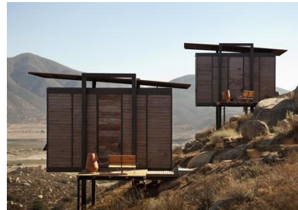
Figura 57. Techos inclinados para circulación del viento en los interiores. Pilotes para minimizar su impacto en la tierra.
