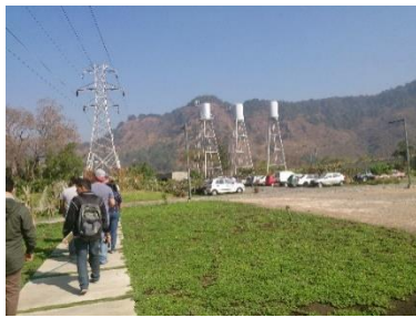
Figura 32. Tanques elevados de agua que funcionan a presión por gravedad.
