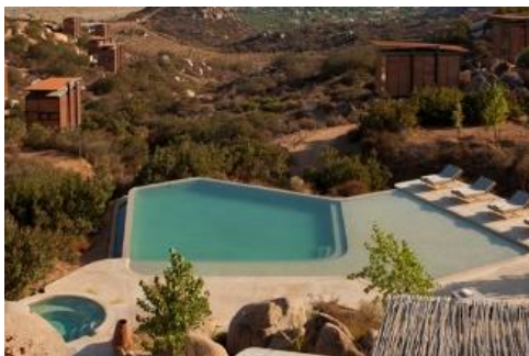
Figura 53. La combinación de la piedra, la madera y concreto visto ofrecen sobriedad, una característica muy común de este tipo de arquitectura.
