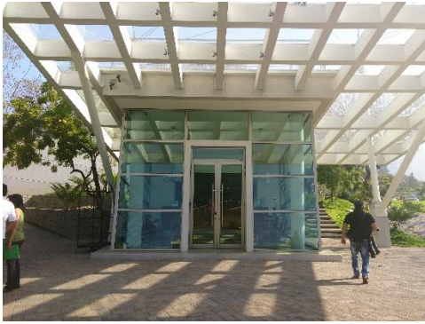
Figura 25. Utilización de la transparencia para aprovechar la luz natural en los ambientes, dividir espacios y dar mayor visibilidad.
