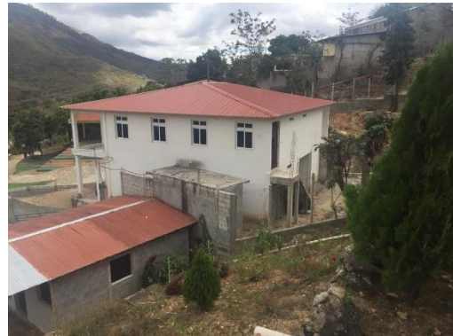
Figura 101. Tipos de vivienda Fuente: Fotografía propia
