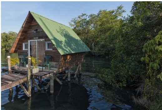
Figura 44. Los bungalows están sobre pilotes permitiendo el flujo de ventilación dando frescura a las habitaciones.
