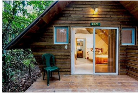
Figura 38. Madera como material predominante en piso, muros y techos.
