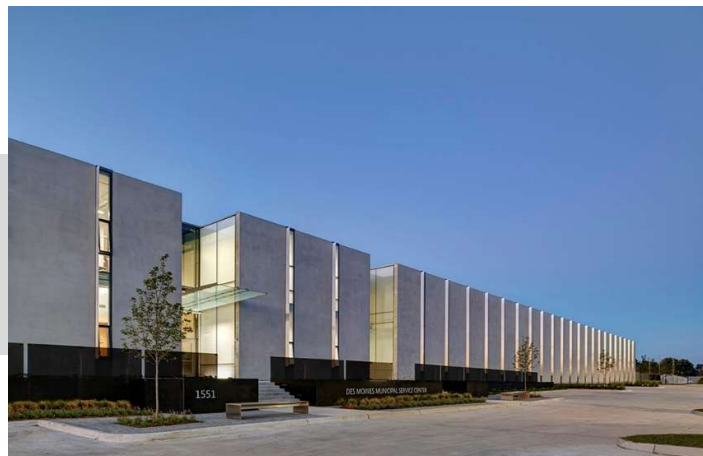
Figura No. 22 Edificios Municipales Des Moines, Estados Unidos.
