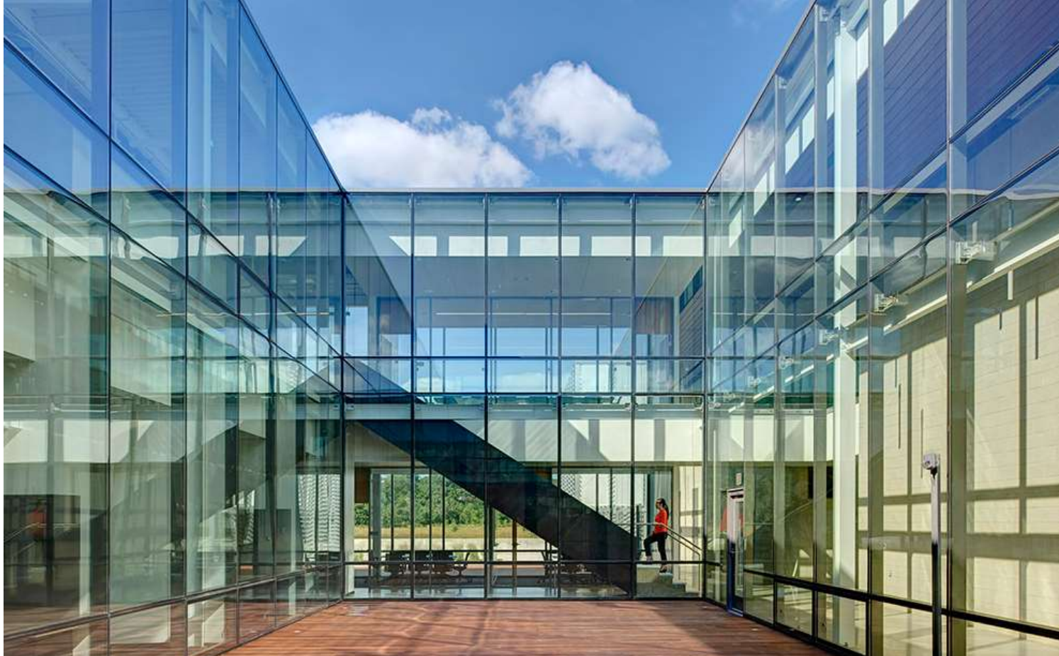
Figura No. 36 Centro De Servicios Municipales De Des Moines Referencia: Plataforma arquitectura
