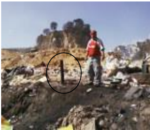
Figura 36. Chimeneas (Tubos que sirven para la salida de gas metano)
