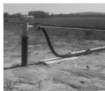
Foto 3: Cabezal de dren horizontal
