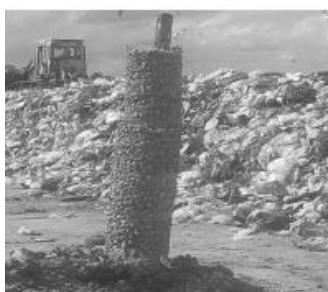
Foto 2: Pozo levantado al construir el relleno
