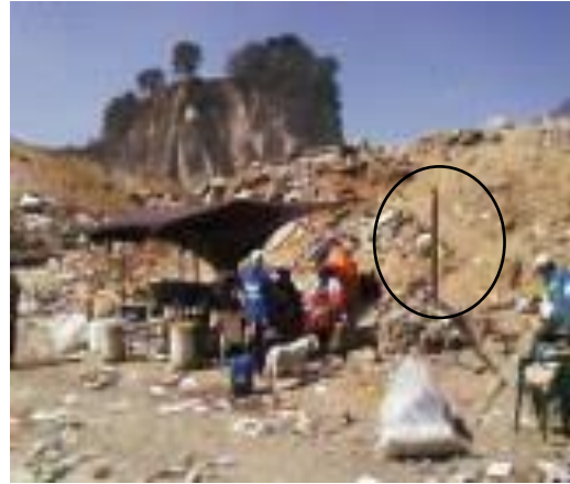
Figura 36. Chimeneas (Tubos que sirven para la salida de gas metano)
