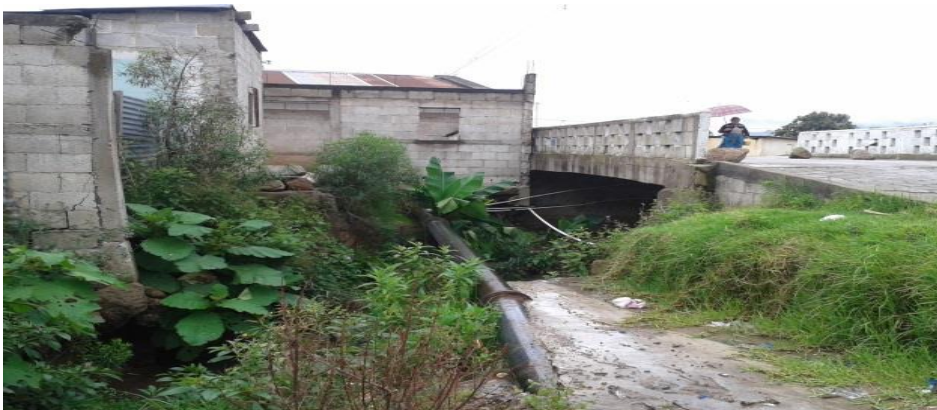
Imagen 6. Vista del río que cambia su cauce y atraviesa la calle del aserradero. Se puede observar la tubería de conducción de agua potable que se ubica bajo una vivienda, asimismo se observan los cimientos expuestos de las viviendas. Fotografía Manuel Montufar
