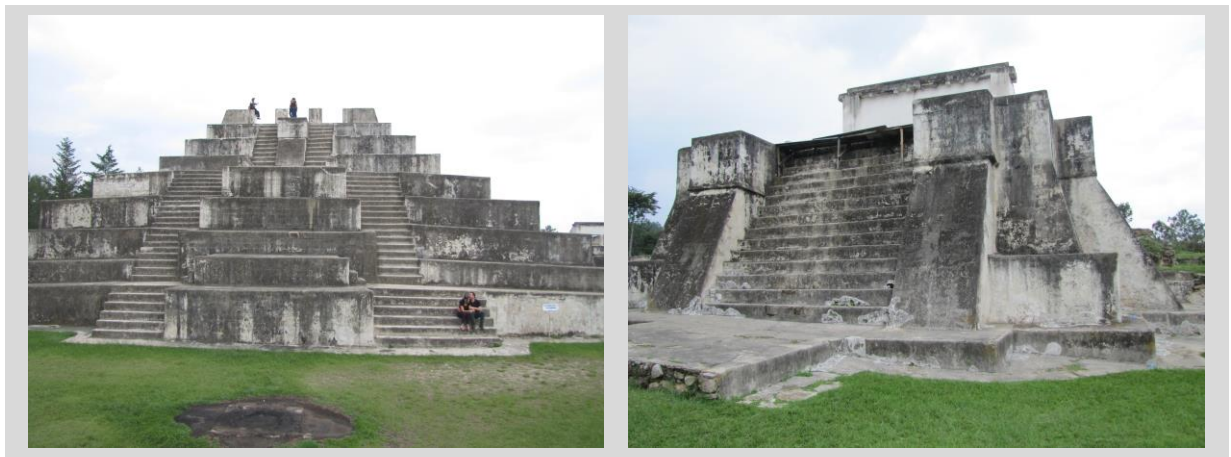
Figura III.29 Edificaciones de Zaculeu (fotografías: de León Mónica, 2017).
