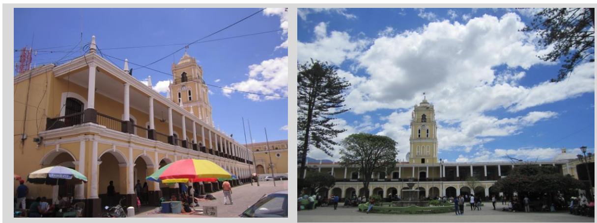
Figura III.34 Edificio de Gobernación (fotografías: de León Mónica, 2018).
