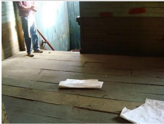
Figura 70. (Izquierda arriba): Detalle de entablado de madera empleado en el 2º nivel.
