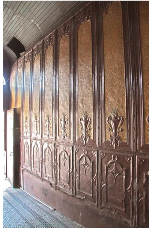
Figura 12. (Izquierda) Detalle de lámina troquelada en zaguán de la Casa 139 (desaparecida por desmantelamiento).
