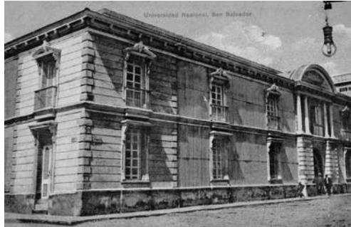
Figura 4. (Arriba a la izquierda): Antiguo edificio de la UES a base de mampostería, madera y lámina.
