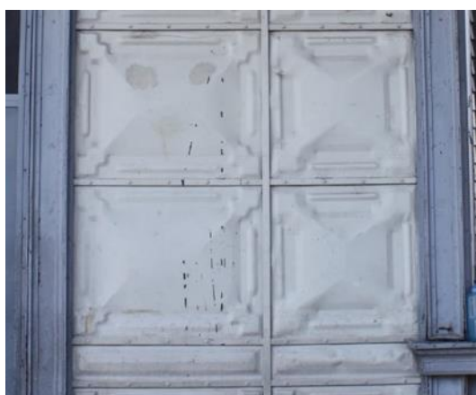
Figura 11. (Derecha) Detalle de lámina troquelada con dos modulaciones distintas en el CDI del Sagrado Corazón.
