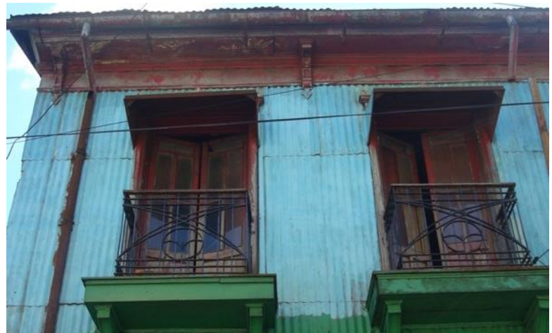
Figura 48. Detalle de un segmento de la fachada para identificar la modulación de la lámina, la cual no se corresponde con la disposición de las aberturas.
