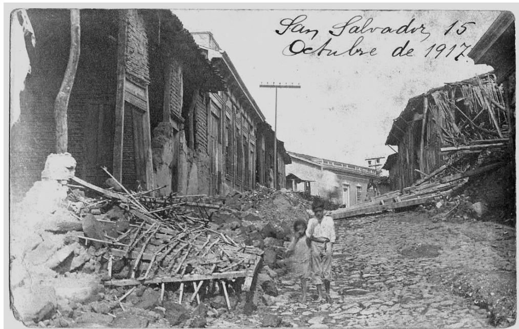
Figura 7. Postal en la que se observan casas de bahareque parcialmente destruidas y edificaciones en pie, probablemente de lámina y madera (al centro de la foto).
