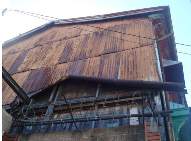
Figura 104. Vista desde la colindancia a la pared oriente de la Casa Verde. Nótese la pérdida de recubrimiento de lámina en el área donde fue demolida la casa vecina, además de la falta de arrostramiento diagonal en la estructura principal del 1º y 2º nivel.
