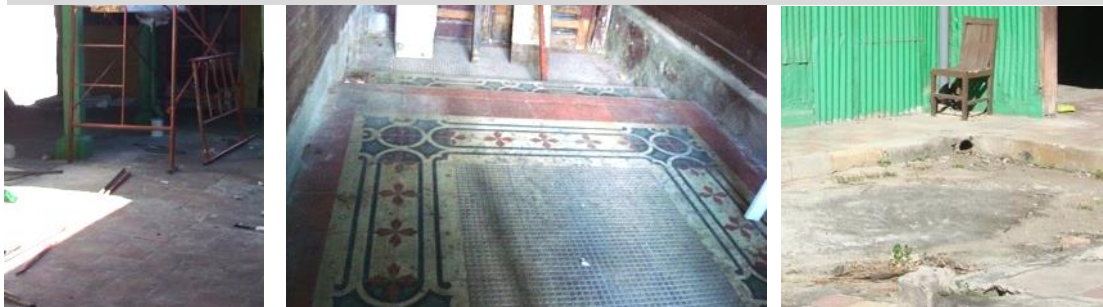
Figura 74. (Izquierda): Patio central. (Centro): Piso tipo alfombra y texturizado empleado en el zaguán de acceso. (Derecha): Patio rústico de concreto.
