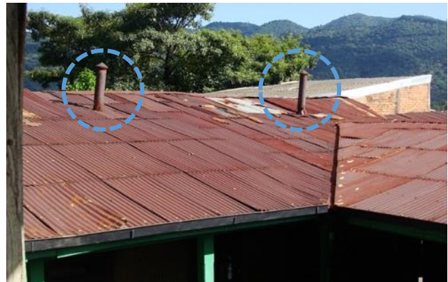
Figura 44. Chimeneas metálicas sobre la cubierta para la extracción del aire caliente.
