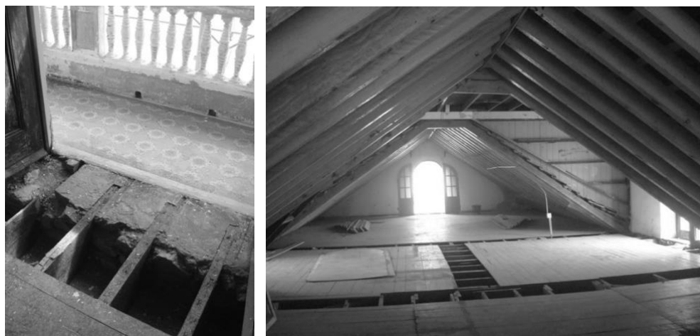
Figura 107. Ejemplos del procedimiento de inspección del estado de conservación de la estructura de entrepisos por medio del levantamiento del entablado en la Casa de la Municipalidad del Casco Antiguo de Panamá. (Izquierda) Vigas de madera en la unión con el muro y corredor exterior. (Derecha) Levantado del entablado en el ático en zonas donde había presencia de goteras.
