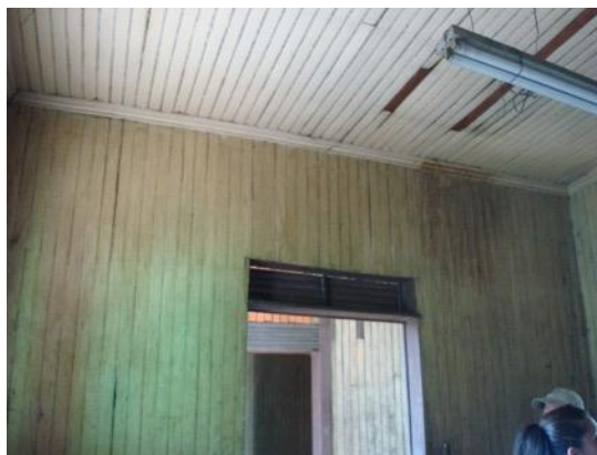
Figura 70. (Izquierda arriba): Detalle de entablado de madera empleado en el 2º nivel.
