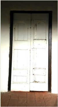
ILUSTRACION 76. RAJADURA EN PUERTA DE LA SACRISTIA POR INTENTO DE ROBO. FUENTE: PROPIO
