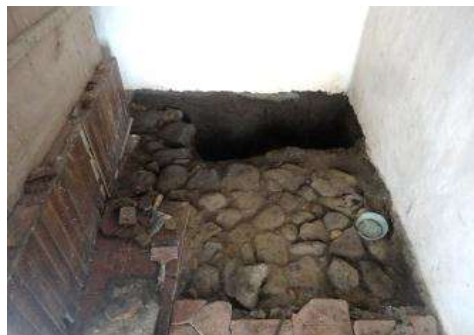
Ilustración 60 Área final descubierta. Se puede observar la cama de piedra bola así como el agujero que se encontraba relleno de arena gruesa. Fuente: Propia
