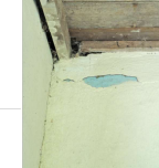
FOTO EN PLANO 35. DESPRENDIMIENTO DE ACABADO EN PARED. FUENTE: PROPIA 201
