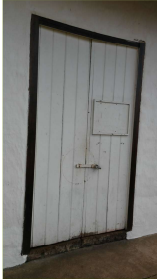
ILUSTRACION 77. PUERTA LATERAL CON DETERIORO DE LA PINTURA. FUENTE: PROPIO
