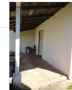
FOTO EN PLANO 37. PISO DESPRENDIENDO, QUEBRADO Y FALIANTE CORREDOR EN SACHISTIA FUENTE: PROPIA 2011
