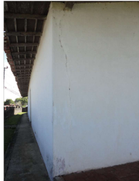
ILUSTRACION 74. GRIETA DESPUES DE ELIMINAR EL REPELLO Y HUMEDAD. FUENTE: PROPIO
