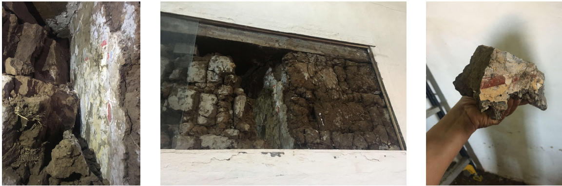
Ilustración 78. Exploración de testigo de pintura mural en jamba de puerta clausurada.
