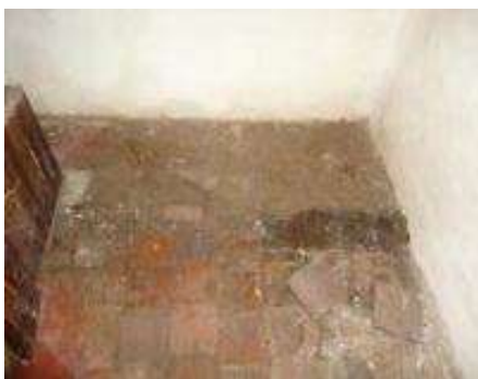
Ilustración 57 El área seleccionada fue la esquina suroeste que no tenía loseta de barro. Fuente propia
