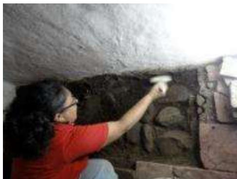
Ilustración 59 Quitando 0.60 cms de loseta de barro aún no se encontró el borde del cimiento. Fuente: Propia
