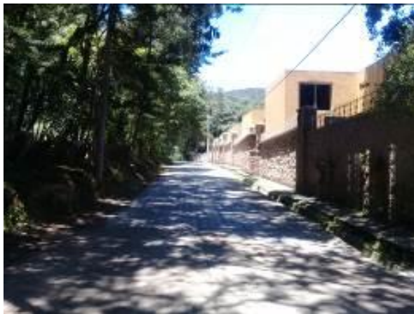
Figura 16. Adoquinamiento de camino (2ª. Avenida del Tronco 2) dentro de los Residenciales Campestres El Encinal zona 7 de Mixco, el cual ya se encontraba establecido previo a la entrada en vigencia del Plan Maestro de la RFPMCA.
