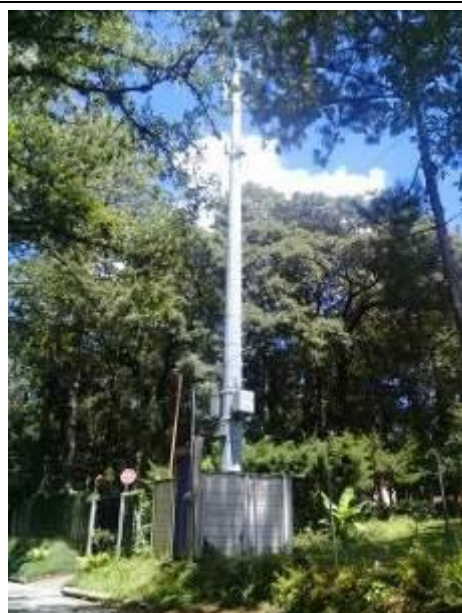
Figura 22. Monoposte de 20.00 metros de altura ocupando un área de 6.00m 2 .
