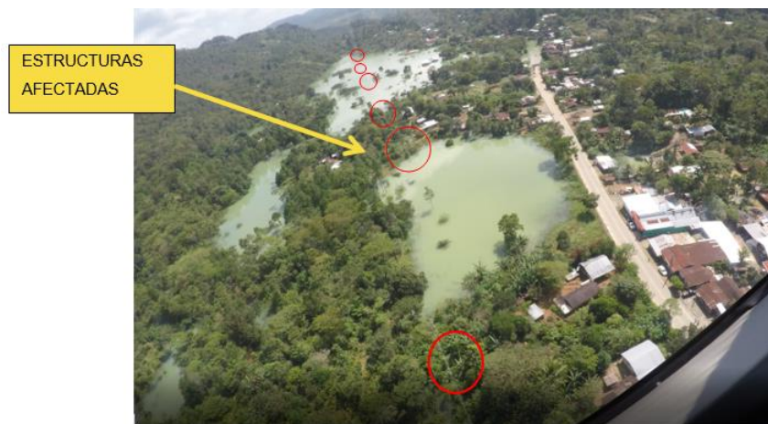
Figura 10. Inundación del tramo de línea Visión del Águila – Chisec
