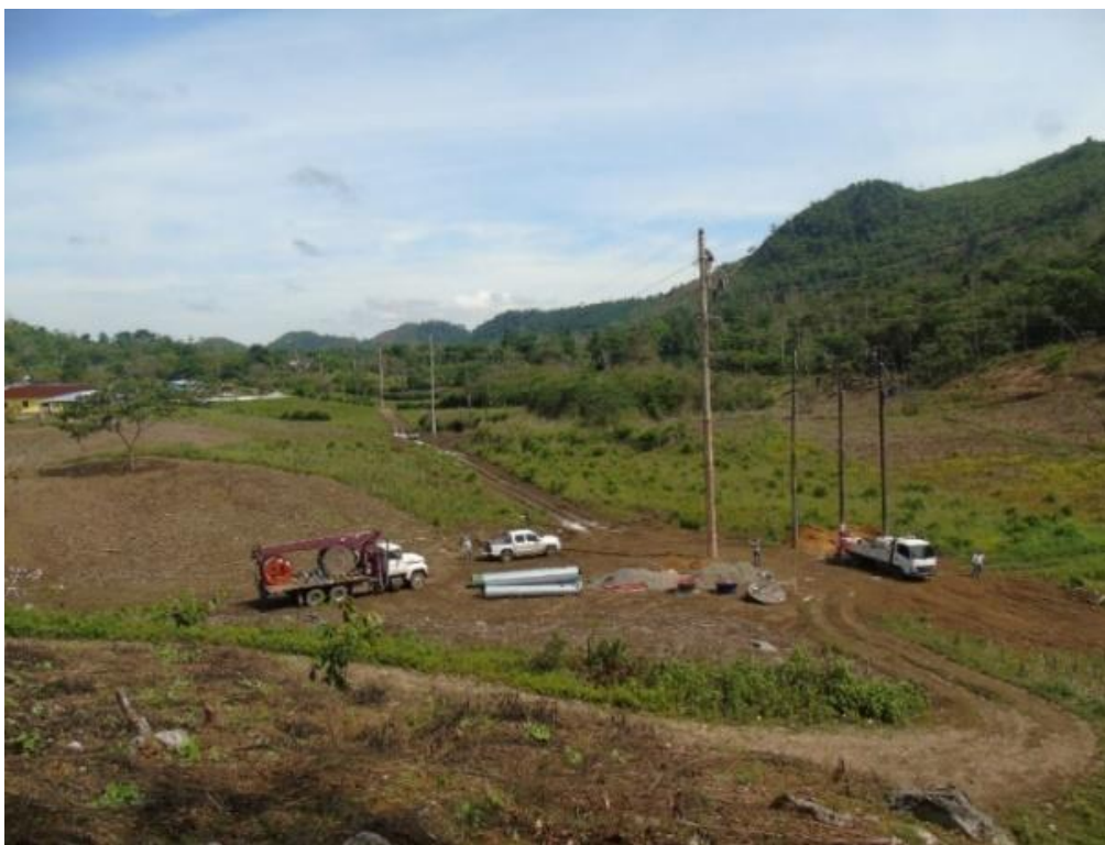
Figura 13. Elevación y cambio de trazo de línea 69 kV con cambio de poste
