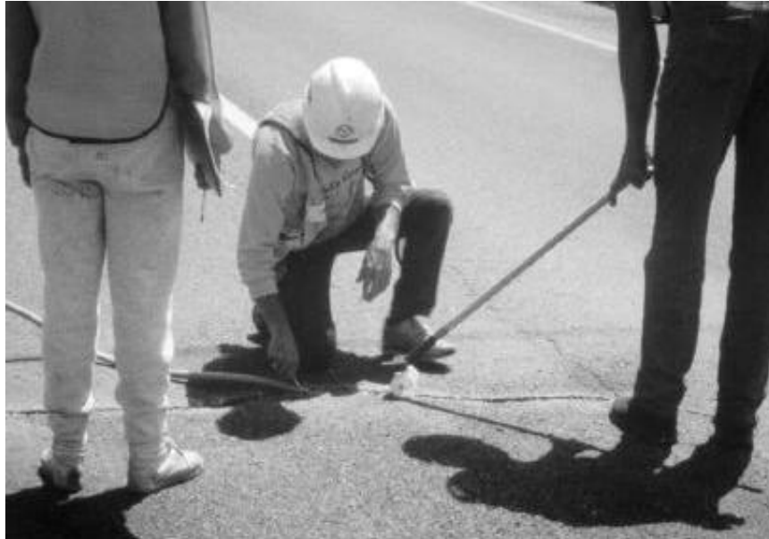
Figura 29. Instalación del cordón de respaldo
