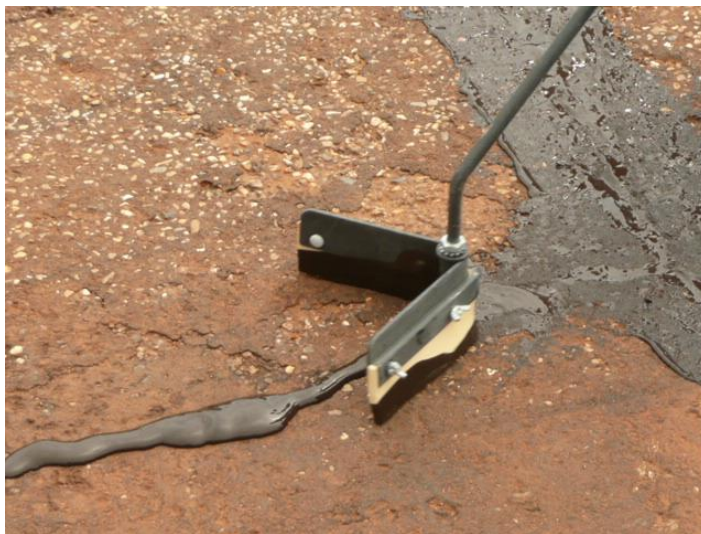
Figura 32. Dispositivo de goma moldeada en forma de V
