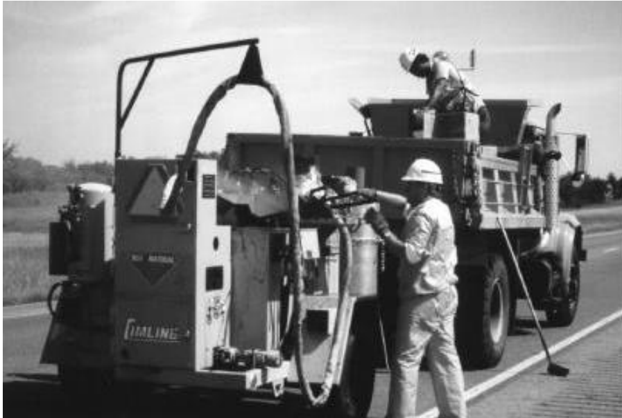
Figura 31. Caldera de asfalto con aplicador de presión
