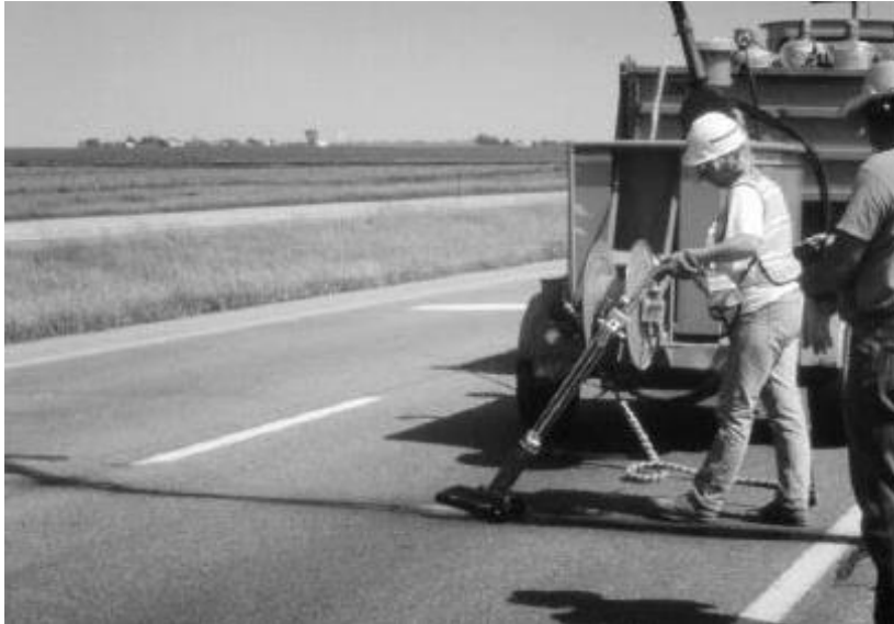
Figura 26. Aire a presión en caliente ( hot airblasting )
