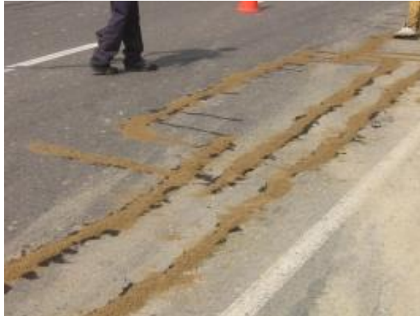
Figura 23. Material secante aplicado en tratamiento de grietas
