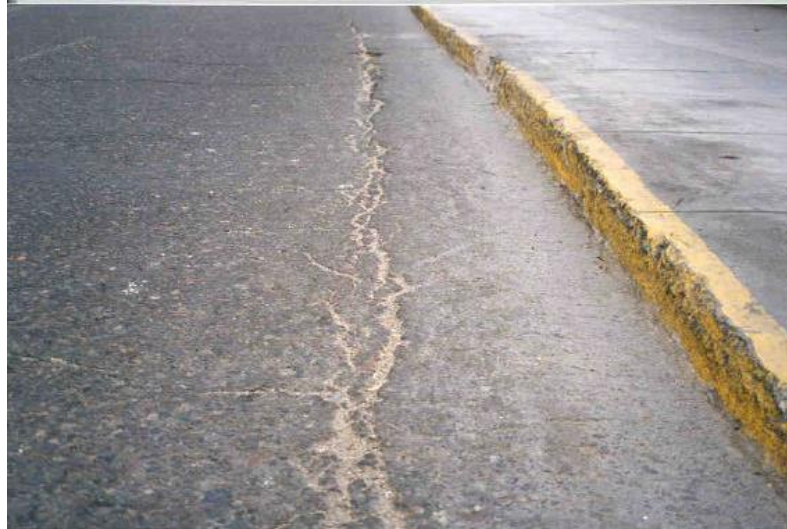
Figura 8. Severidad media de agrietamiento de borde
