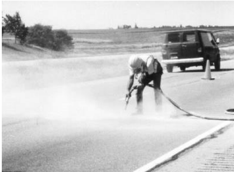
Figura 27. Aire a presión con arena ( sandblasting )
