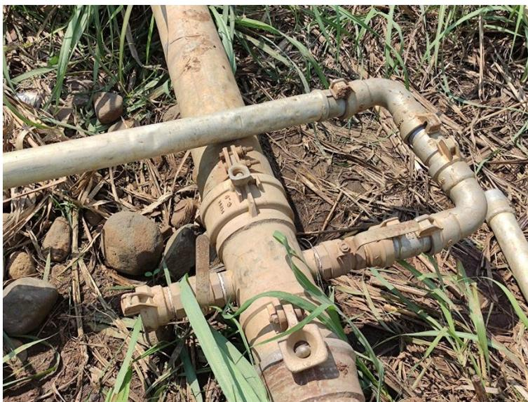
**Figura 12: Tubería principal de 8 pulgadas con reductores de 2.5 pulgadas en el sistema de riego de baja presión, ubicado en Finca Vaquil sección 2.**
