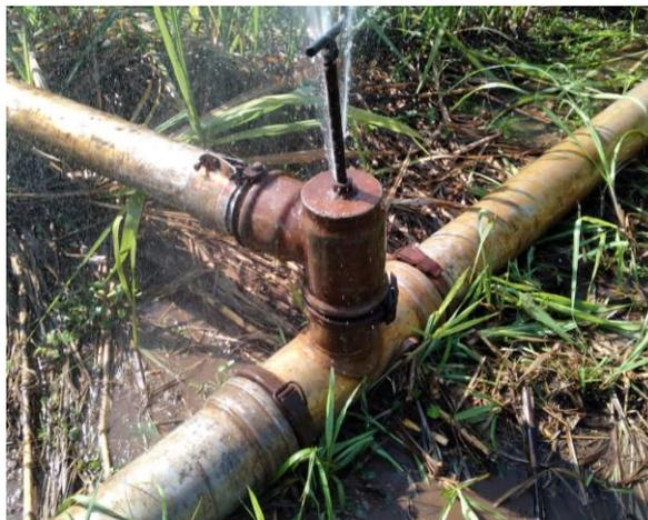
**Figura 14: Unión de tubería principal de 8" con tubería secundaria de 6" en riego de alta presión.**
