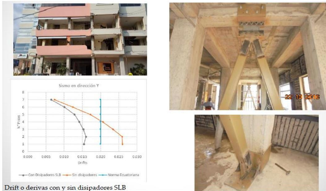
Fuente: Bozzo, L. (2021). *Análisis y diseño utilizando disipadores sísmicos tipo SLB*. pág. 18.
